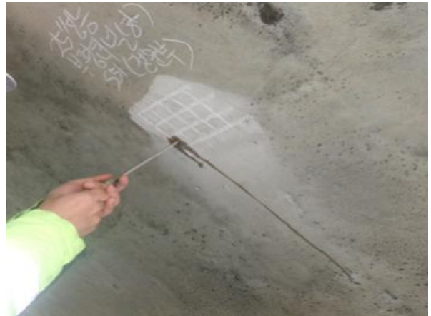
탄산화 깊이 측정
