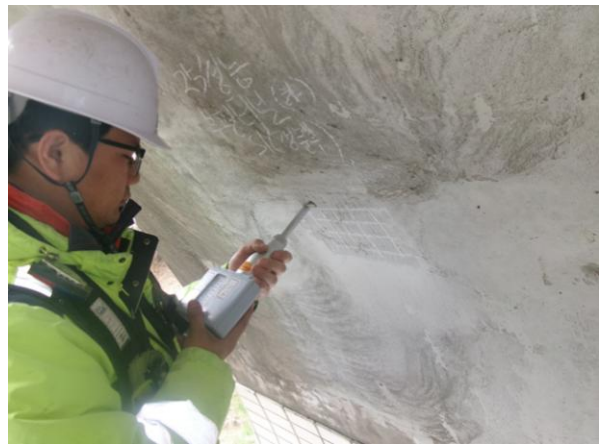
터널 라이닝 비파괴시험
