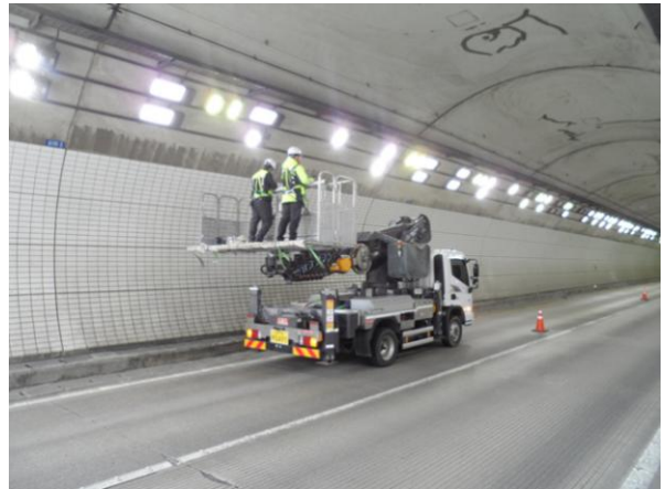
고소점검차를 이용한 근접조사
